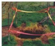
Mouvement de terrain (cavités souterraines)
